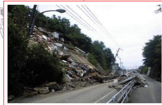
広仁方停車場線（広津久茂）片側交互通行
