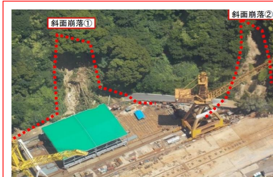
呉環状線警固屋8丁目（警固屋ドック付近）
