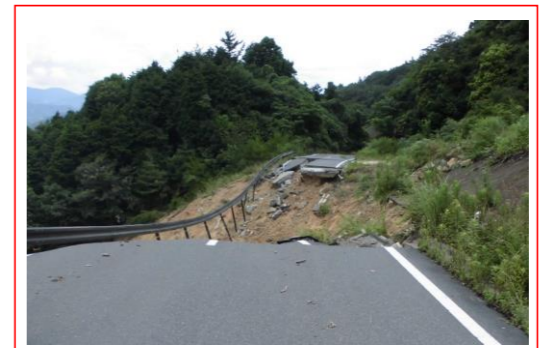
ふるさと林道 郷原野呂山線（呉市管理）通行止め
