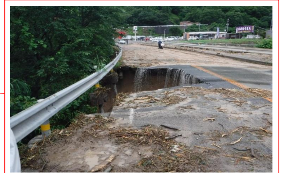
国道185号仁方町（川尻越ヶツイルブン前）仮復旧
