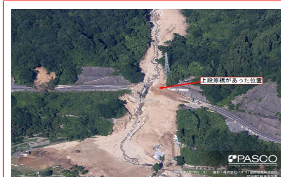
国道375号二級峡ノ下（上段原橋）仮復旧
