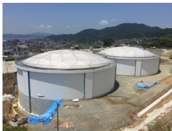
平原低区配水池 (H29 年度完成予定)
