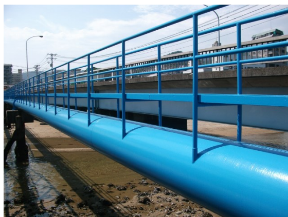
水管橋の塗装（二河川・かもめ橋）
