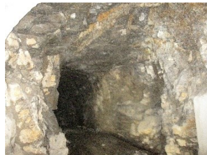
本庄導水線路 第1 隧道内
