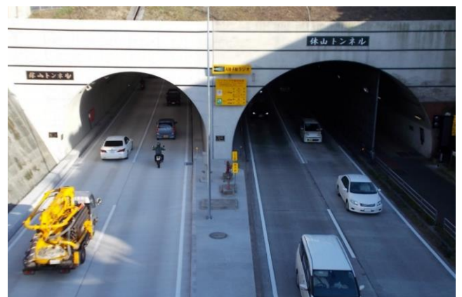
4車線化完成後の状況
