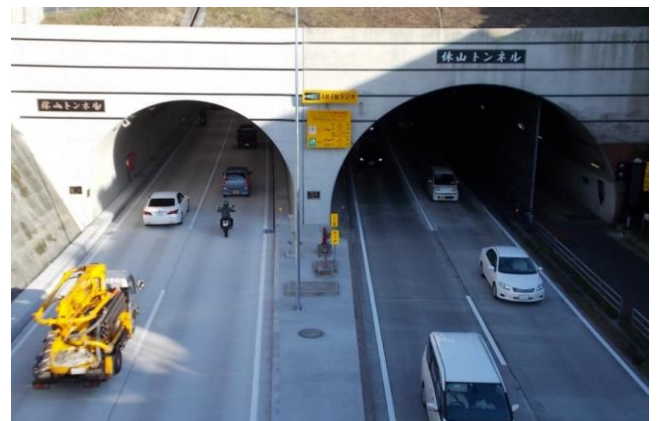
4 車線化完成後の状況
