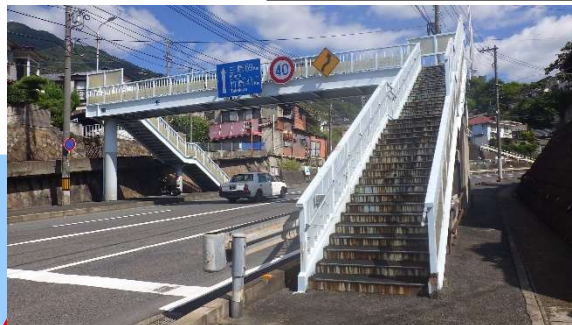
畑横断歩道橋 L=43.4m (鋼橋)1969年架設
