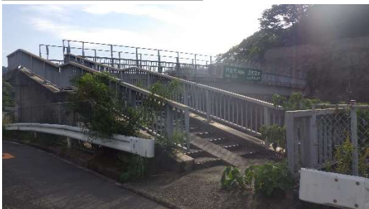
天應山陸橋 L=39.9m (PC橋)1988年架設
