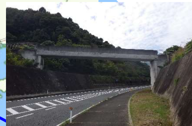
水尻跨道橋 L=27.0m (PC橋)1998年架設
