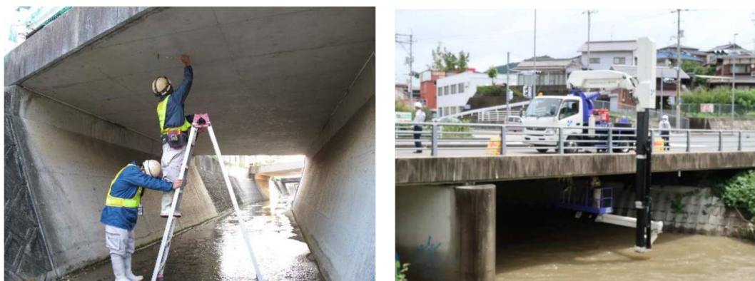
橋梁定期点検状況
