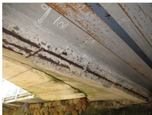
主桁のうき・剥離・鉄筋露出
