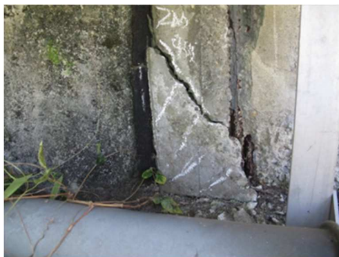
主桁のうき・剥離・鉄筋露出
