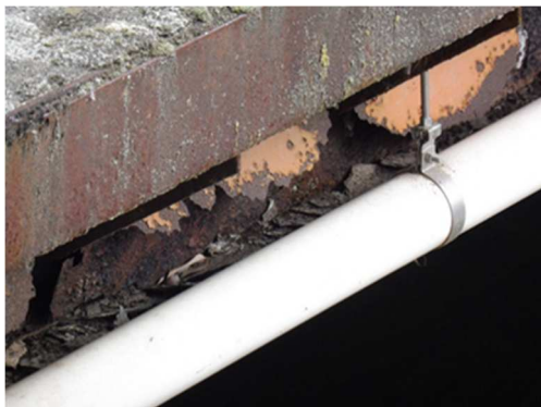
主桁の腐食
