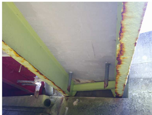
主桁の腐食
