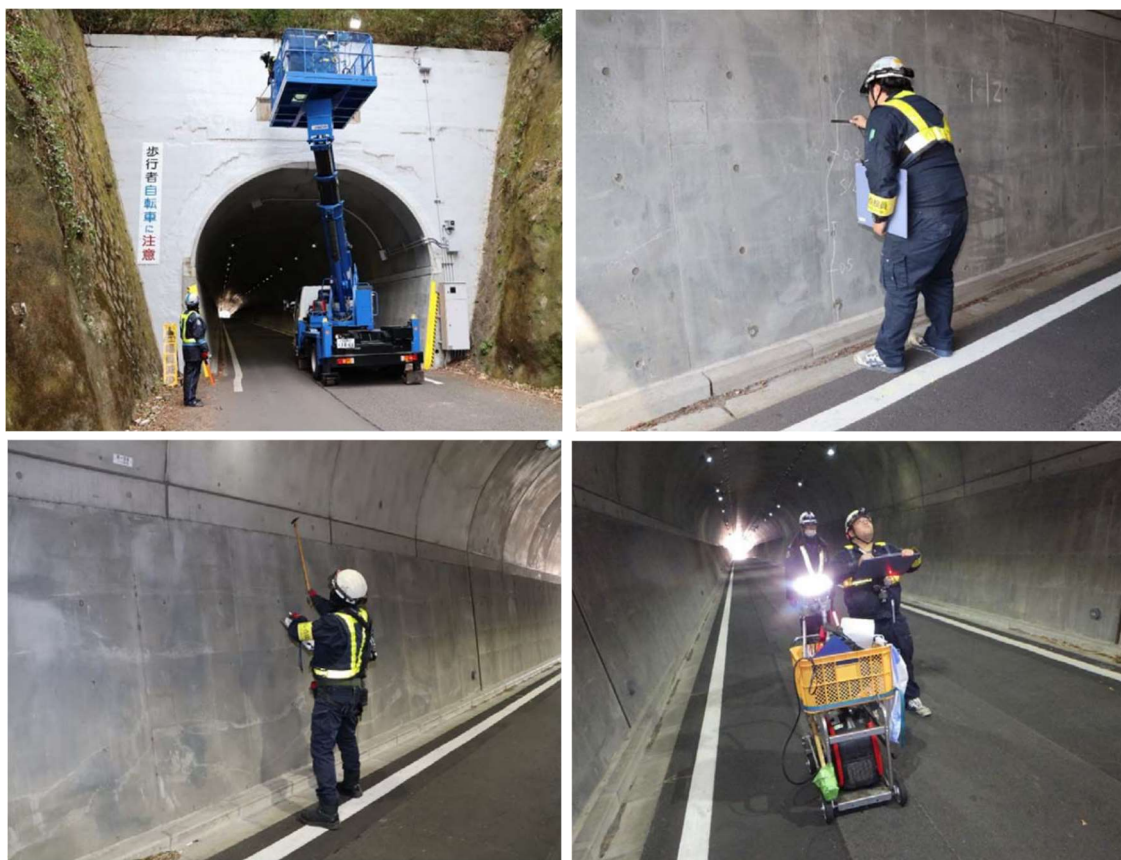
トンネル定期点検状況
