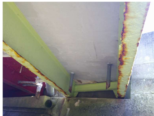
主桁の腐食
