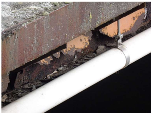
主桁の腐食
