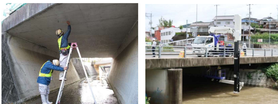
橋梁定期点検状況
