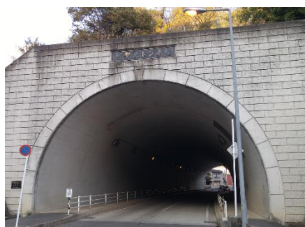
【阿賀北トンネル】
