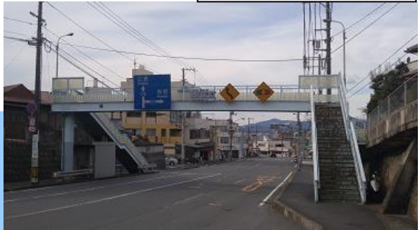
畑横断歩道橋 L=41.6m (鋼橋)1969年架設
