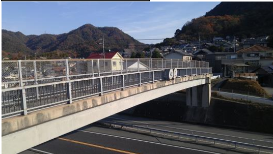
天應山陸橋 L=39.9m (PC橋)1988年架設
