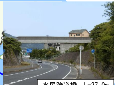
水尻跨道橋 L=27.0m (PC橋)1998年架設
