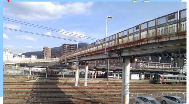
広駅跨線橋 L=278.6m (鋼橋)1987年架設
