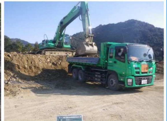
掘削土の積み
