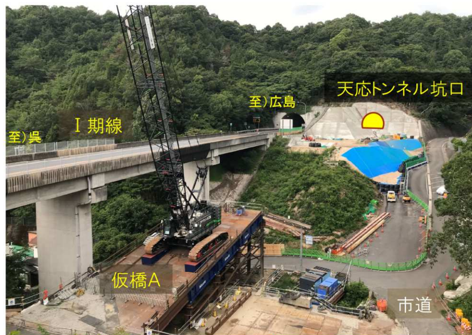
仮橋A工事状況写真
