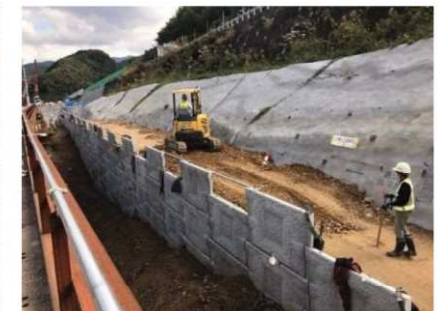
擁壁盛土作業
