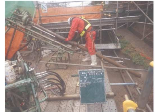
アンカー設置作業
