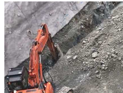
基礎の掘削作業
