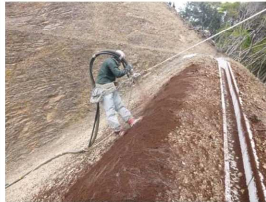
のり面吹付作業
