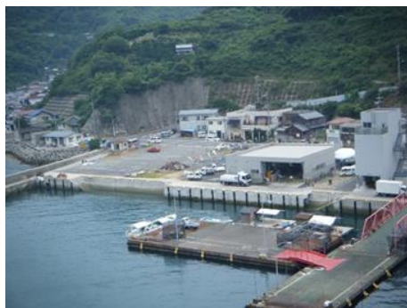
製氷・貯氷施設及び荷さばき施設
