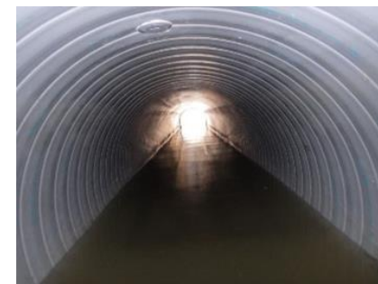
更生工事完了後の下水道管
