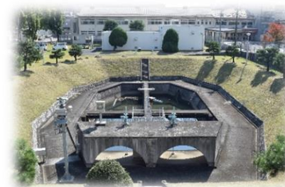
廃止した戸坂取水場
