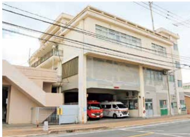
▲老朽化が進む東消防署川尻出張所
