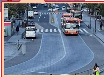
通常のアスファルト舗装ではなく、ブロック系の舗装材を使用
