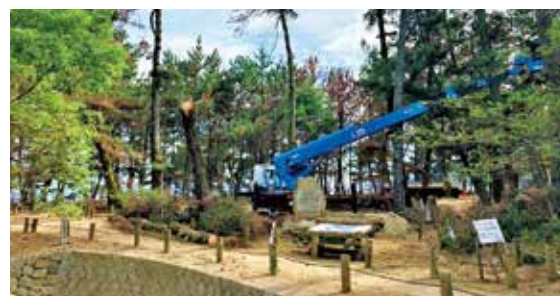
▲桂浜の枯れた松の撤去
