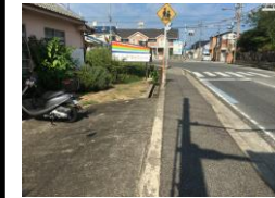
28-5:側溝に落下の危険性がある
