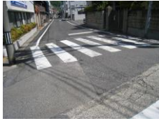
30-5:見通しが悪く、車両と接触する危険性がある
