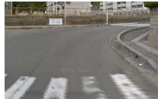
26-18 : 歩道が狭く道路にはみ出し危険
