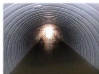
更生工事完了後の下水道管
