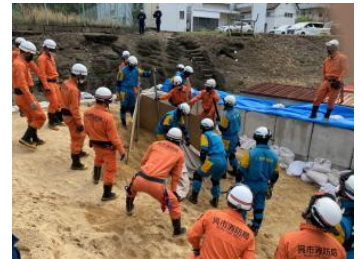
他機関・近隣消防本部との合同訓練の様子
