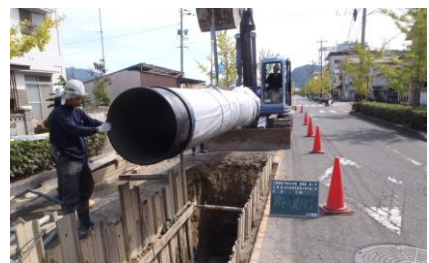
口径800mmの管路更新工事
