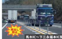
※東広島・呉自動車道と同様な道路にワイヤロープを設置し、対向車線への飛び出し事故が約95%減少
