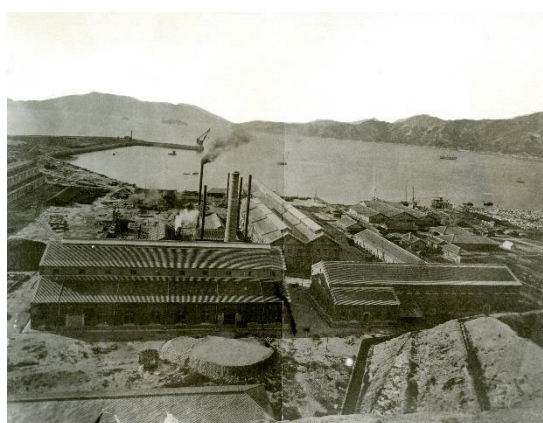
レンガ造などの工場がつぎつぎと誕生する呉海軍造兵廠（明治 30（1897）年）
