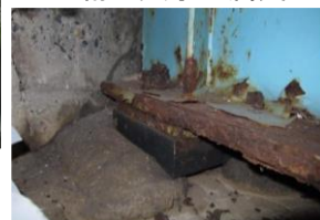
主桁・支承 腐食
