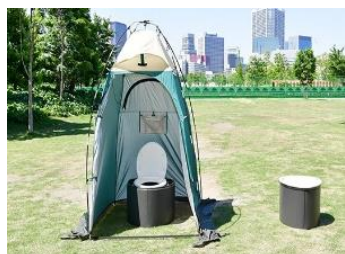
マンホールトイレ
