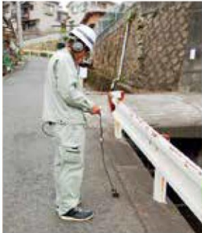
漏水探知機を使った漏水調査
