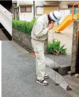
音聴棒を使った漏水調査
