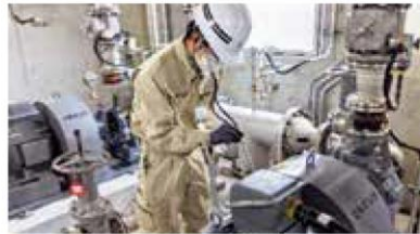
サウンドスコープを使ったポンプの点検
