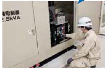
設備の運転時の温度を測り、作業音を聞くなど、稼動状況を感じ取ること、保守点検時の大事な作業です。[柳迫第1ポンプ所]
