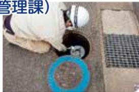
水圧を抑える減圧弁が正常に作動しているか点検しています。
