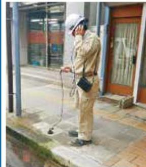
漏水探知機を使った漏水調査
