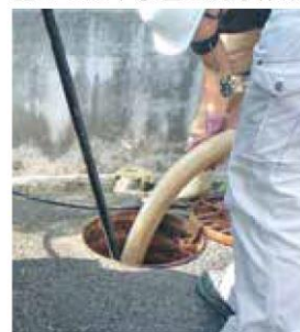
詰まった下水管の洗浄作業
