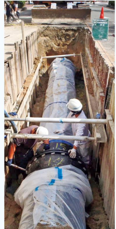
水道管耐震管布設工事現場
