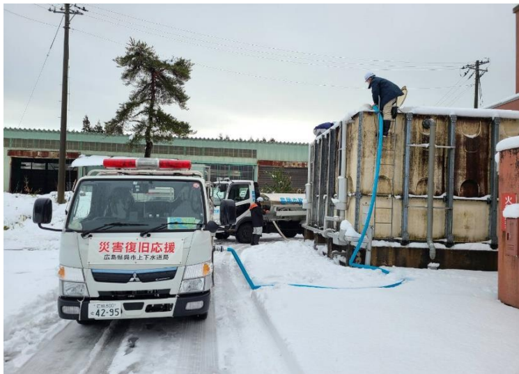
要配慮者利用施設の受水槽への充水作業
