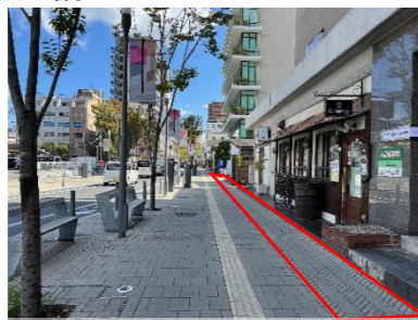
1m の部分の舗装の仕上げを区別
