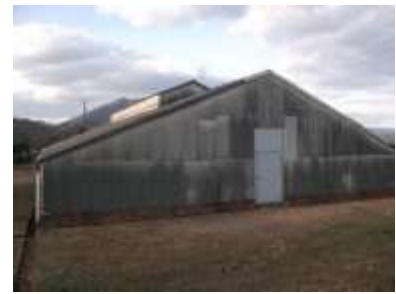
○名田山配水池（広島地区） 大正14年築造
