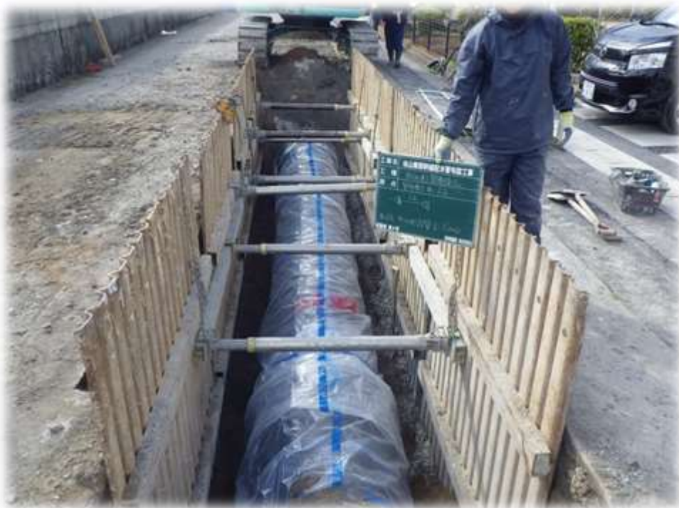
管路更新工事
