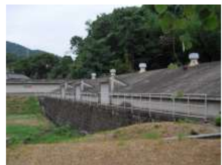
○鍋崎配水池（中央地区） 明治36年築造
