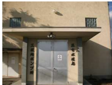
○三坂地ポンプ所（広地区） 昭和31年築造
