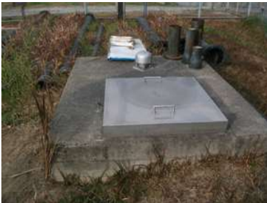
○三坂地水源地（広地区） 大正10年築造
