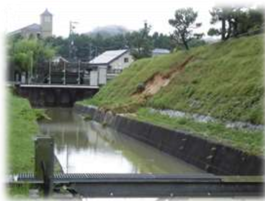
三永水源地 取水口
