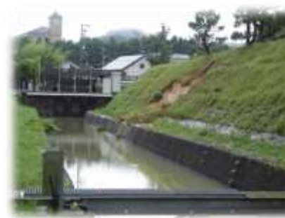
三永水源地 取水口
