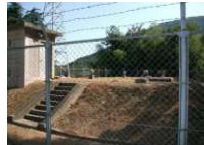
仁方低区配水池（仁方地区） 昭和 25 年築造
