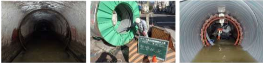
工事前の下水道管
