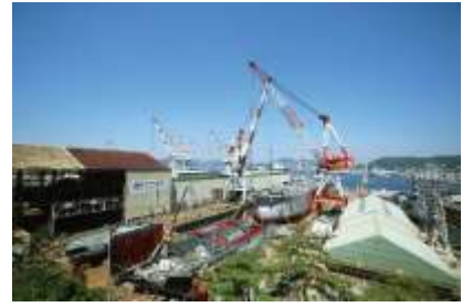
旧海軍工廠造船船渠大屋根（中央）
