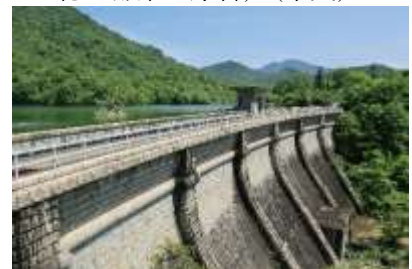
本庄水源地堰堤（昭和）
