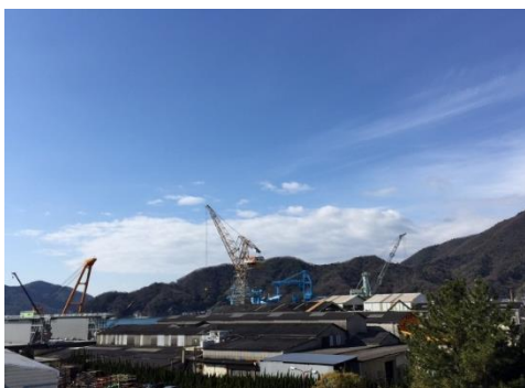
[臨海部の工業団地]
