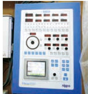
↑統合型環境制御装置。温度・二酸化炭素量などを複合的に管理
