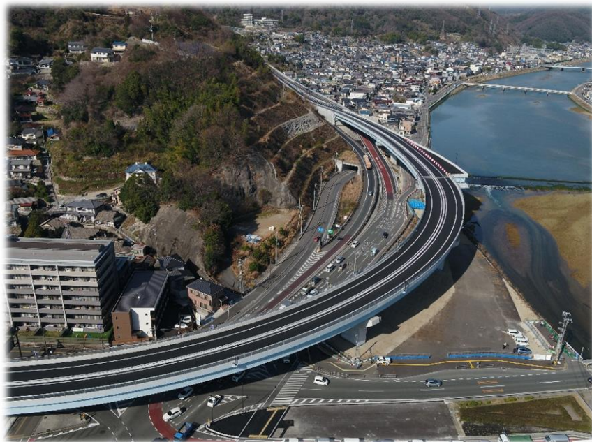
東広島・呉自動車道 阿賀IC立体化事業 (令和4年3月完成)
