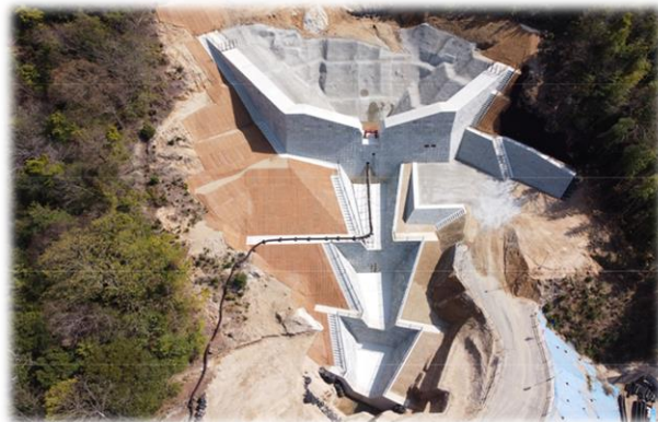
整備中の砂防ダム (大屋大川，天応中学校東側) 国土交通省広島西部山系砂防事務所提供
