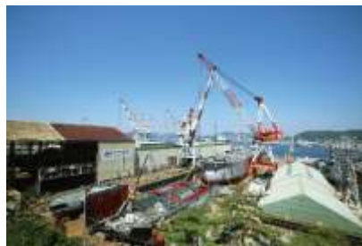
旧海軍工廠造船船渠大屋根（中央）
