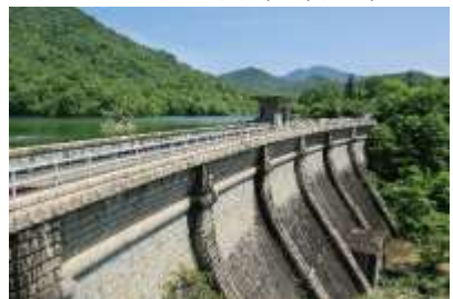
本庄水源地堰堤（昭和）
