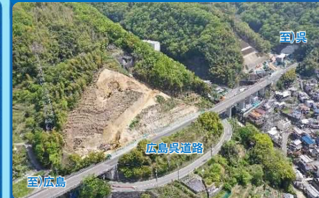
③ 呉トンネル吉浦側坑口付近
