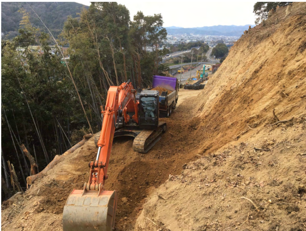
バックハウ & ダンプトラック
