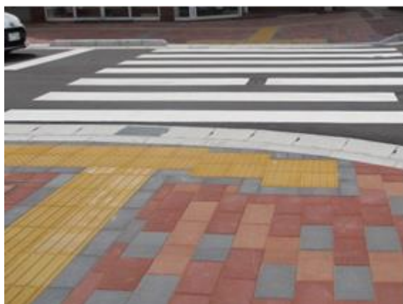
視覚障害者誘導ブロック設置
