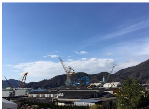
[臨海部の工業団地]
