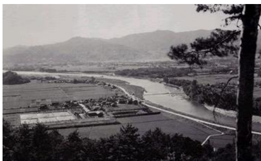
昭和 27 年 戸坂浄水場
