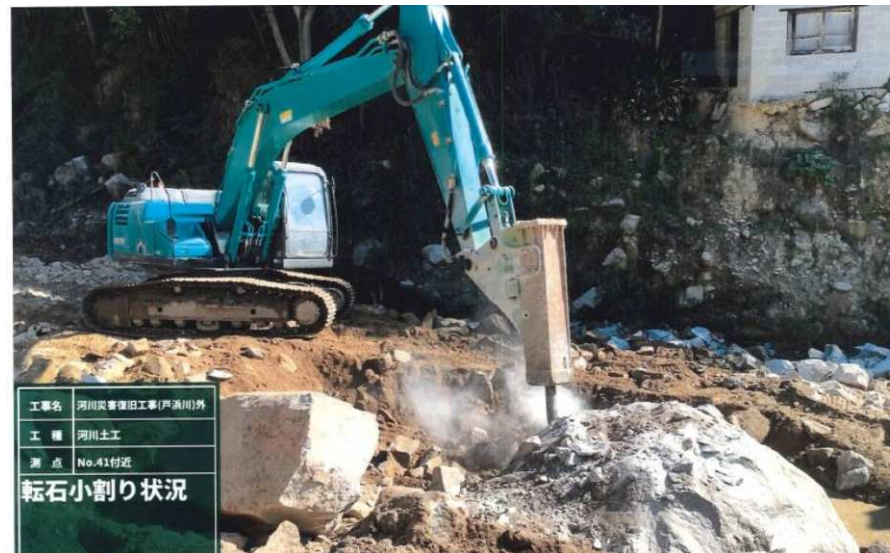
転石の破碎処理状況写真
