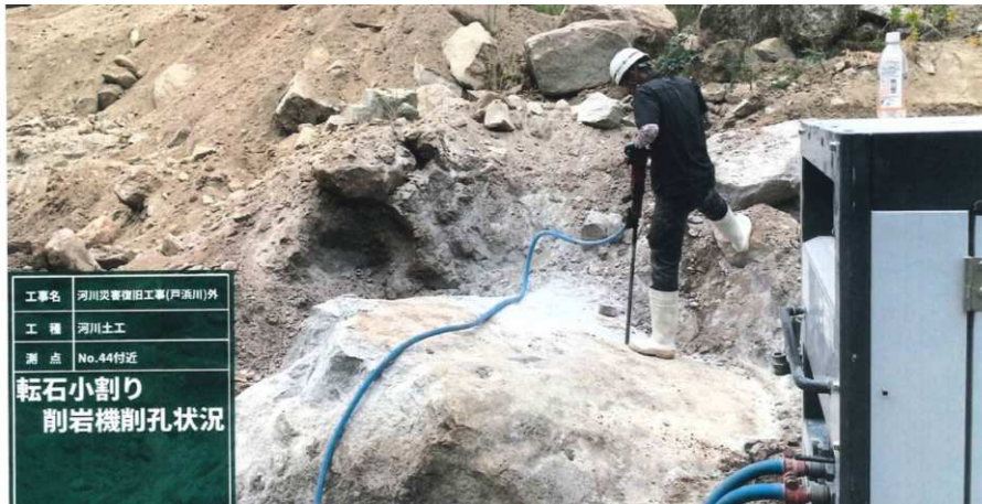
転石の破碎処理状況写真
