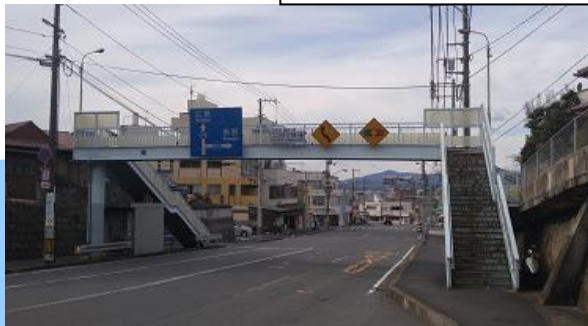
畑横断歩道橋 L=41.6m (鋼橋)1969年架設
