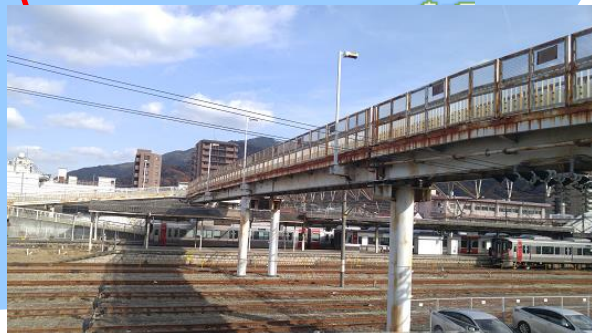
広駅跨線橋 L=278.6m (鋼橋)1987年架設
