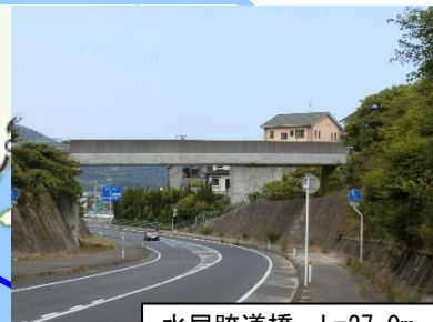
水尻跨道橋 L=27.0m (PC橋)1998年架設
