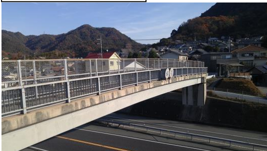
天應山陸橋 L=39.9m (PC橋)1988年架設
