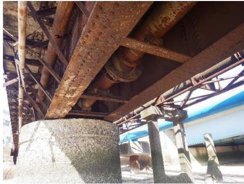
主桁の腐食
