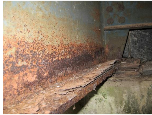
主桁の腐食
