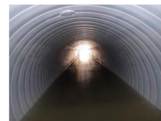
更生工事完了後の下水道管
