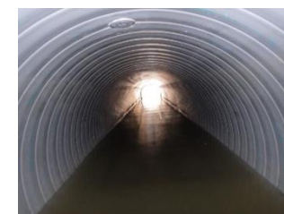
更生工事完了後の下水道管
