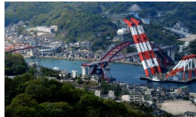
第二音戸大橋上部架設
